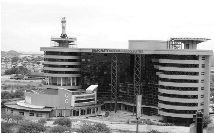
Das im Bau befindliche neue Hauptquartier der SWAPO
